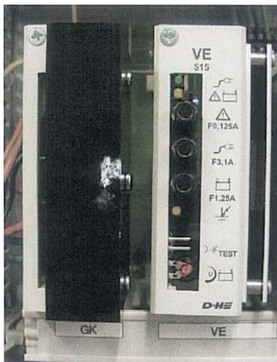
Rys. 11. Wariant układu zasilania centrali RZN 43xx – E składający się z karty prostownika GK 511 i panel zasilacza VE 515
