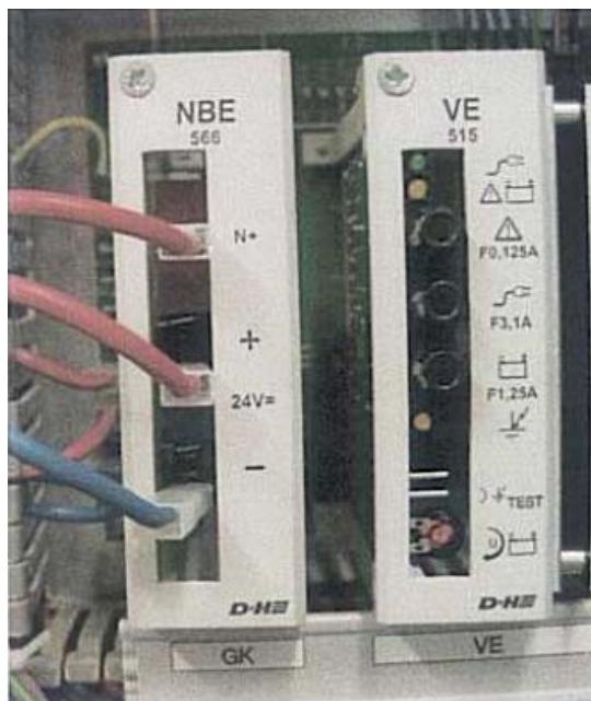
Rys. 10. Regulatory zasilacza centrali RZN 43xx – E typu NBE 566 i VE 515
